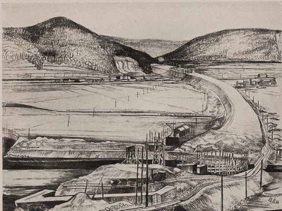
Bauabschnitt der Reichs-Autobahn
